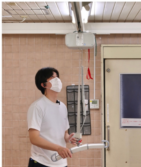
ノーリフティングケア(浴室天井走行型リフト) 天井に取り付けたレールを走行して入浴時の移動・移乗介助を行う為のリフト。広い範囲を移動する事が可能。
